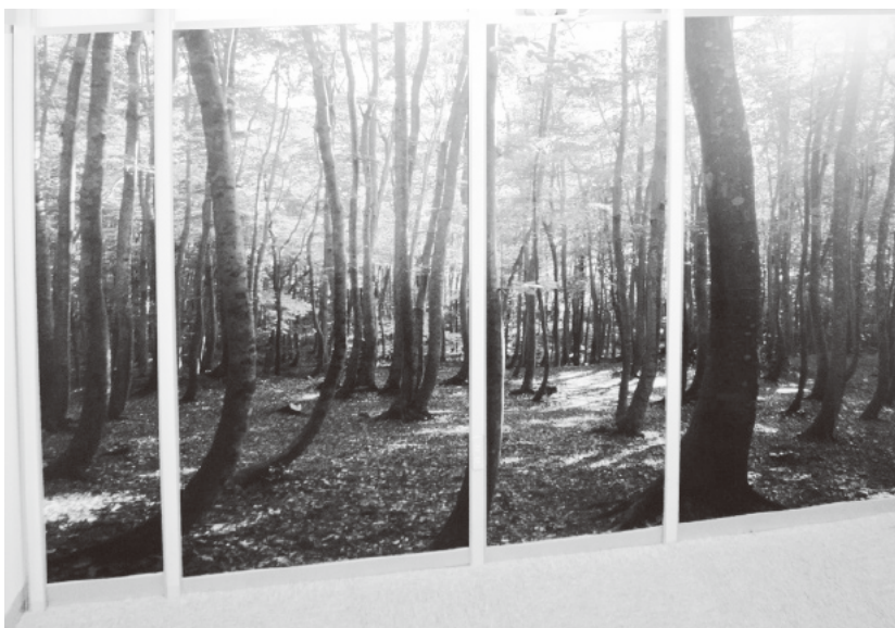
壁に施工した再剥離シート
